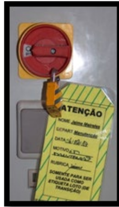
Fig. 26 – Procedimentos Lock-Out/Tag-Out
